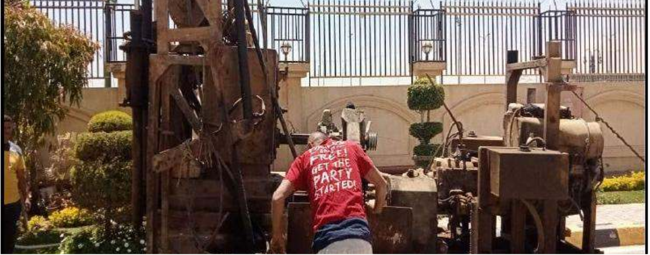
أعمال حساسات وأبحاث تربة ميدانية — أحد مواقع العمل بسوهاج
