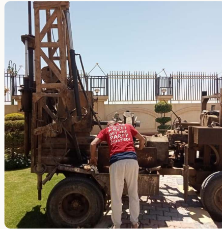
أعمال جسات داخل موقع حكومي
