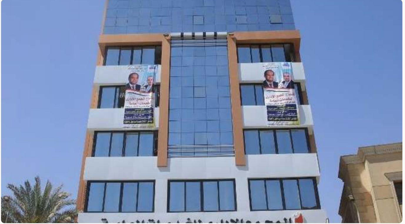
المبنى بعد اكتمال التنفيذ
