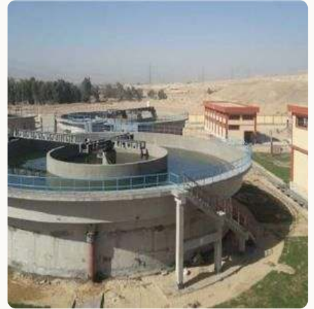
أحواض ترسيب بمحطة معالجة
